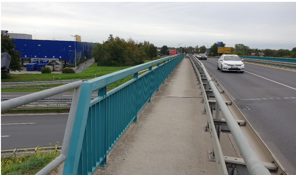
Abbildung 21: Brücke der Berliner Chaussee (ehemalige K 6162) über A 117, Blickrichtung Süden
