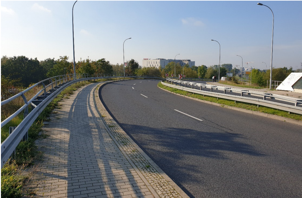
Abbildung 17: Brücke Waltersdorfer Chaussee über Bahnstrecke Berliner Außenring. Blickrichtung Südwest
