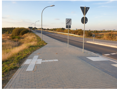
Abbildung 58: Bestand Südseite Kienberger Brücke
