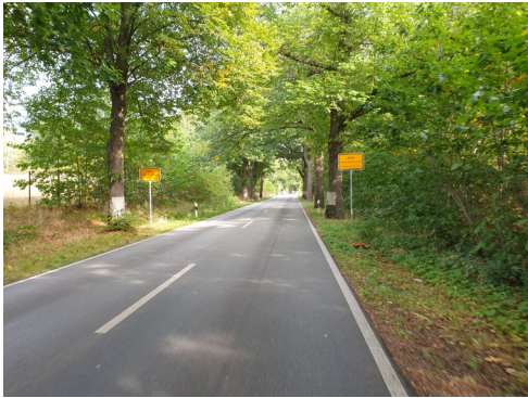
Abbildung 36: Bestand Berliner Straße
