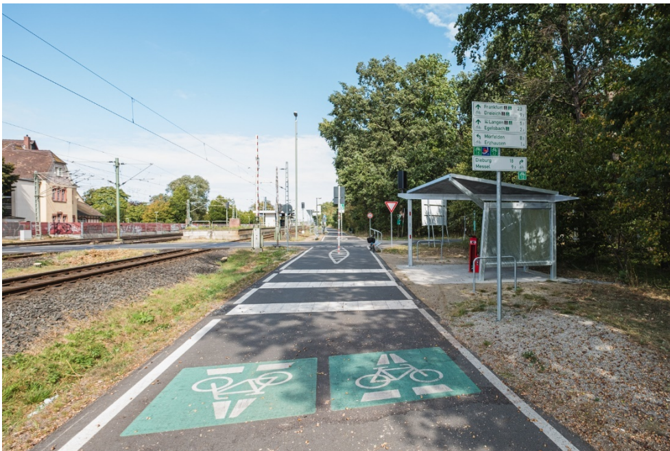
Abbildung 11: Wartepflichtige Querung (Furtmarkierung im Zuge eine RSV (Bsp. RSV Darmstadt-Frankfurt, eigenes Bild)
