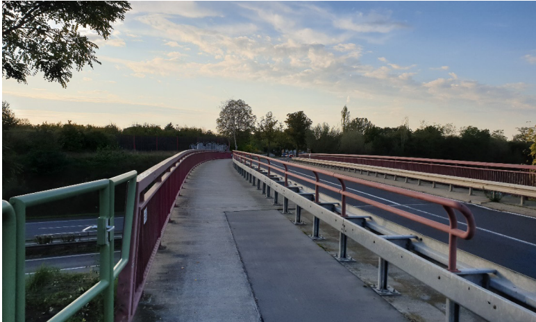
Abbildung 22: Brücke der L 402 über die A 113, Blickrichtung Osten (Kiekebusch)
