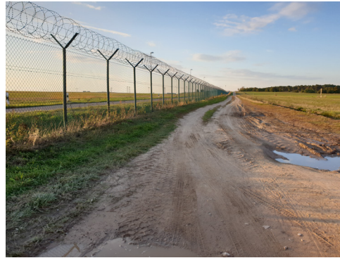
Abbildung 56: Runway 3 entlang des Flughafenzauns im Abschnitt C.2.0
