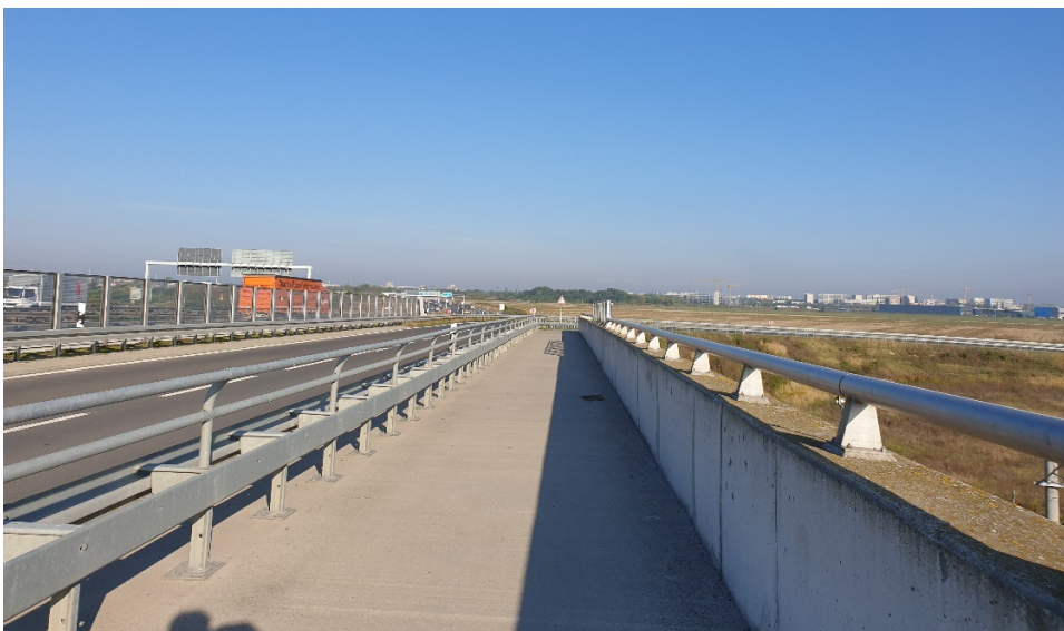
Abbildung 18: Brücke der Berliner Chaussee über die Bahntrasse zum Flughafen, Blickrichtung Norden
