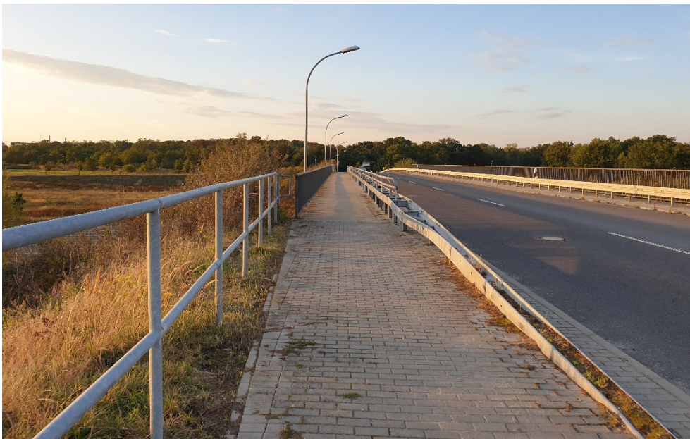
Abbildung 19: Kienberger Brücke (Südrampe, Blickrichtung Norden)
