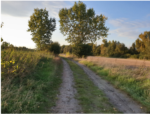
Abbildung 55: Wirtschaftsweg im Abschnitt C.2.0 südlich des Flughafens
