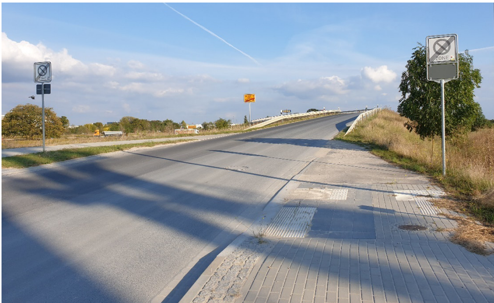
Abbildung 20: Blick auf Brücke der Waltersdorfer Allee über A 113, Blickrichtung Westen
