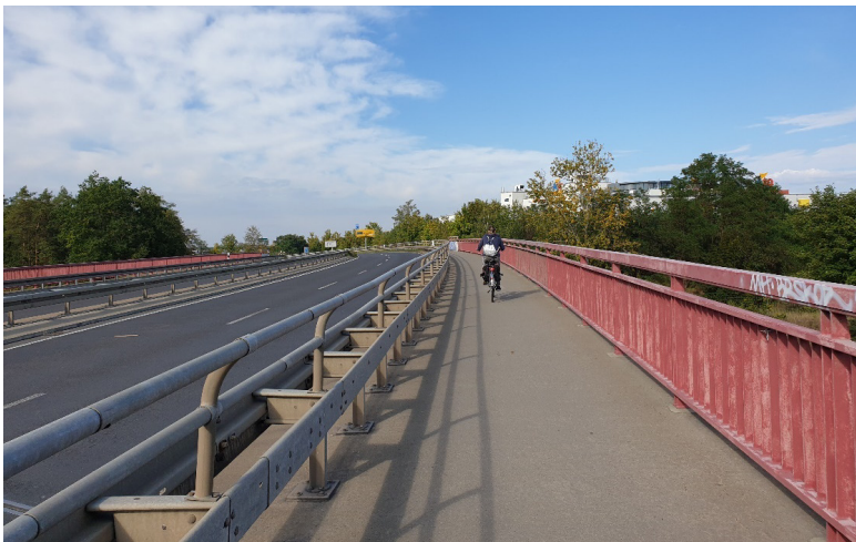
Abbildung 23: Brücke der B 179 über die A 10 (nördlich Königs Wusterhausen), Blickrichtung Norden (A10-Center)
