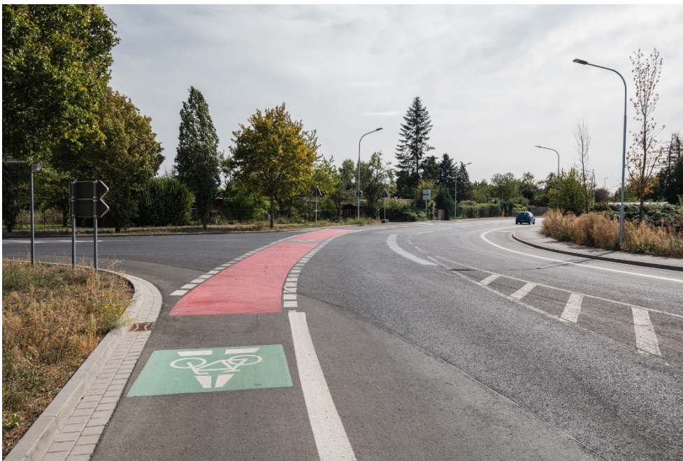
Abbildung 10: Furtmarkierung im Zuge einer RSV (Bsp. RSV Darmstadt-Frankfurt, eigenes Bild)
