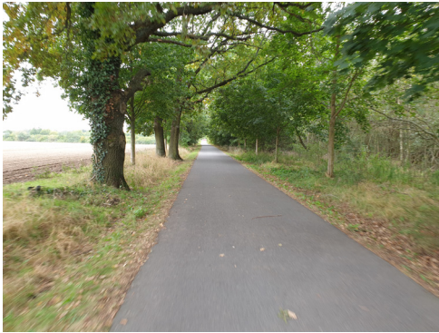
Abbildung 34: Bestand entlang der Goethebahn
