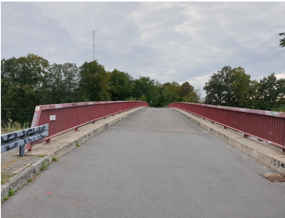
Abbildung 24: Brücke der Goethebahn über die A10, Blickrichtung Süden
