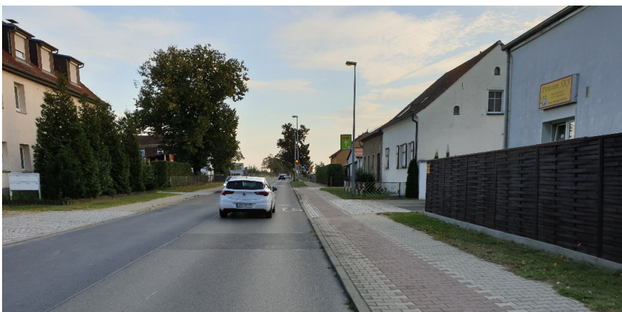
Abbildung 42: Ortsdurchfahrt Waltersdorf. Blickrichtung südlicher Ortsausgang
