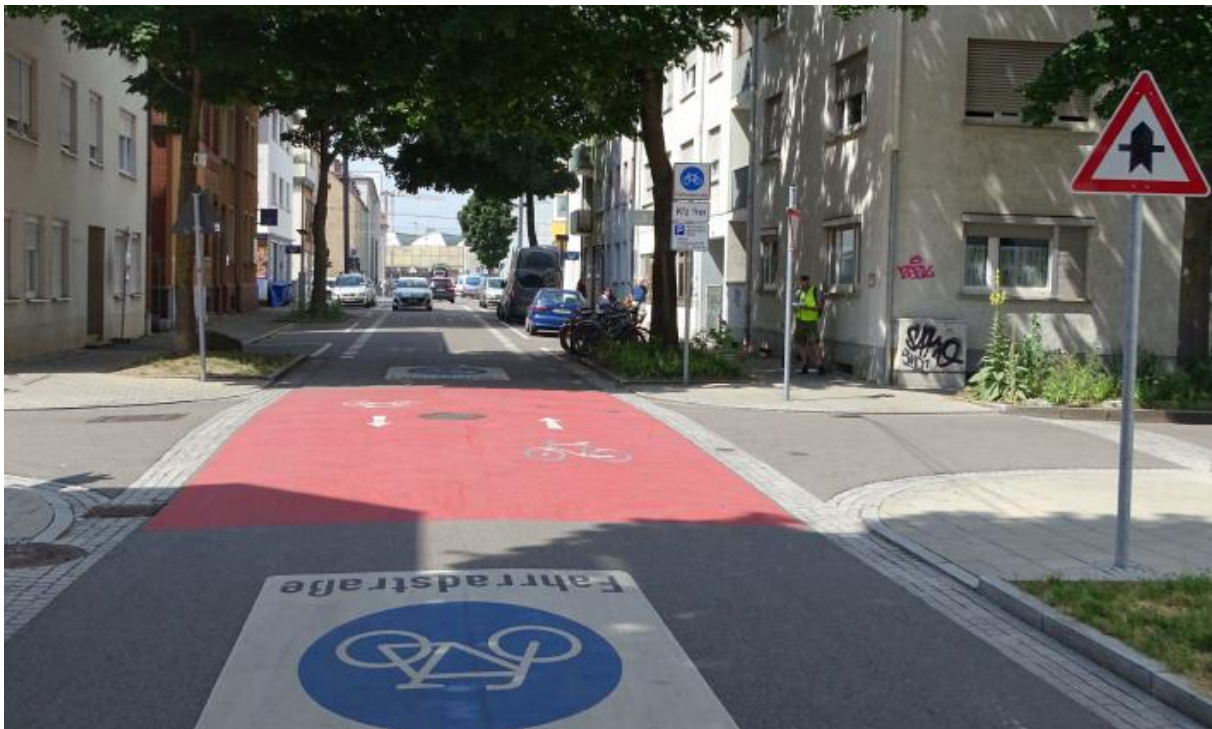
Abbildung 4: Knoten mit angehobener roter Fahrbahnfläche und Bevorrechtigung in Ulm.
